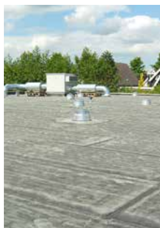
Vue extérieure de plusieurs puits de lumière
