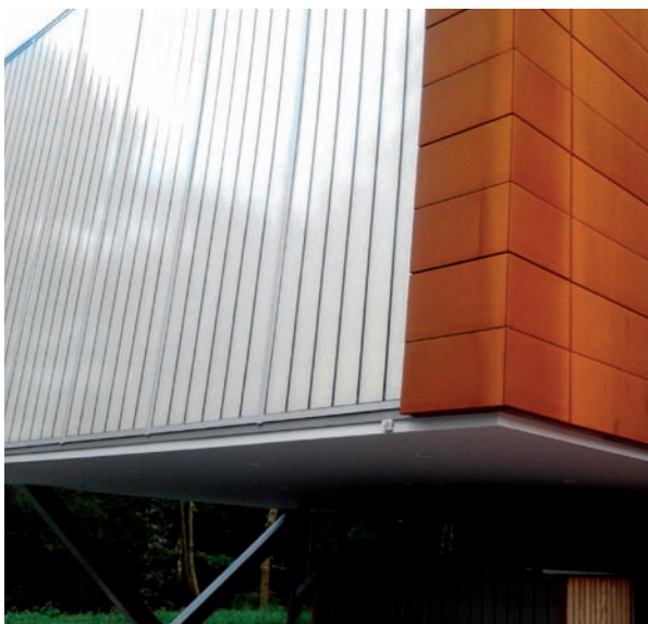
Façade résistante au lancer de ballon et sa structure verticale dans une salle de sport
