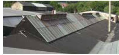
Lichtstraat met zadeldak en draadglas voor renovatie
