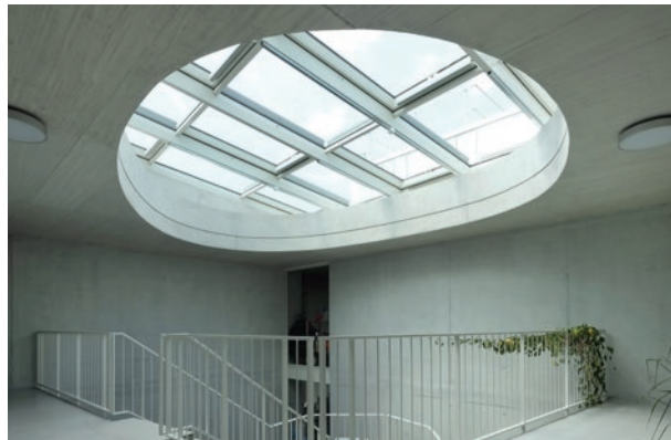
VENTRIA 3 eingebaut als Lüftungsflügel im Pultdach
