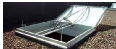
VARIO lichtdoorlatende klep met RWA-apparatuur en elektrische motor na RWA-opening in uiteindelijke positie
