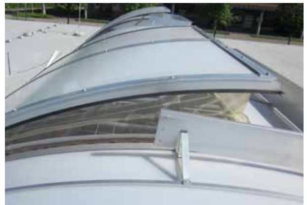
Klep lichtstraat in ventilatiepositie met insectenhor
